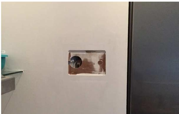
Bei der Variante mit Rahmen wird nach erfolgreichem Einbau, der Rahmen mittels Magnete auf den Wandeinbauhalter gesetzt.
